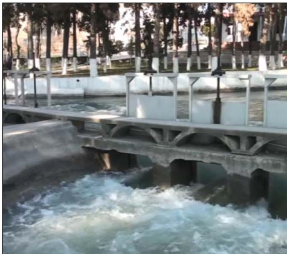
İdarə tərəfindən bu ilin əvvəlindən etibarən 14 ədəd hidrotexniki qurğu vaxtılıq təkili və yararsız hala düşən borular sökülüb yeni borularla əvəzlənərək cari təmir olunub. Bu da nəticə olaraq kollektörlərdə qurunt və səth sularının normal axıdılmasına, torpaqların meliorativ cəhdən yaxşılaşdırılmasına müsbət təsirini göstərib.
